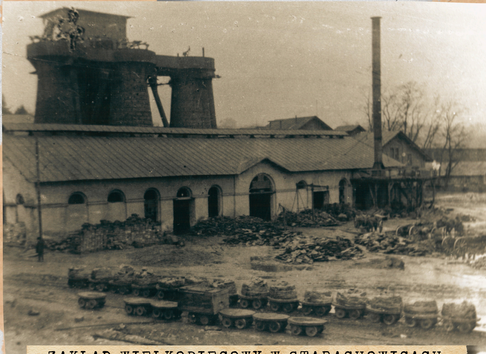
ZAKŁAD WIELKOPIECOWY W STARACHOWICACH Z 1841 ROKU
