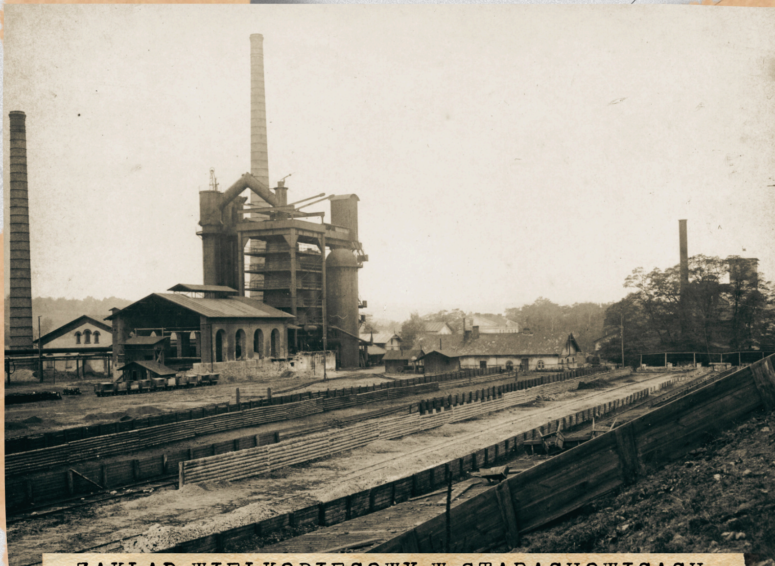
ZAKŁAD WIELKOPIECOWY W STARACHOWICACH Z 1889 ROKU
